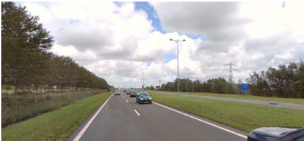
Fig. 4.3 a: Drie Merenweg. Rechts de bestaande 150kV, links begeleidende beplanting, waarachter de 380kV zal worden gerealiseerd.
