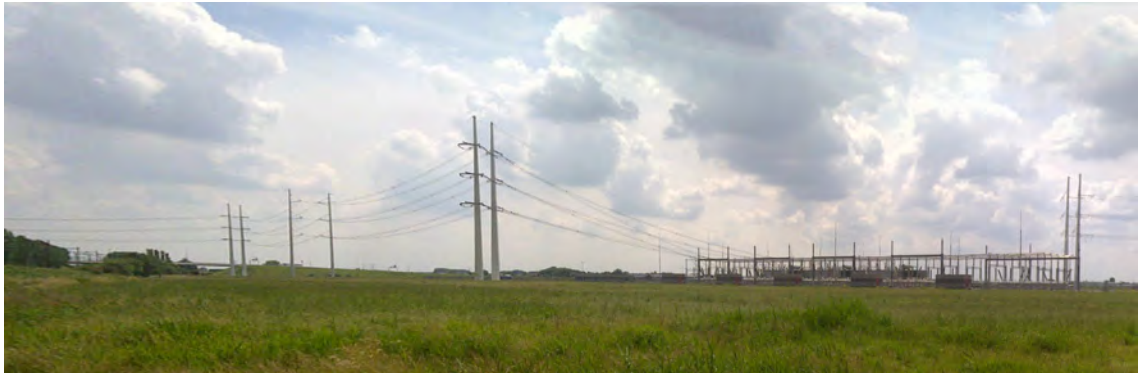
Fig. 4.9d: Beeld van het plangebied in juni 2012. Links de 380kV Krimpenlijn, rechts de R380kV Zuidring in aanbouw. Voor locatie en kijkrichting zie afb 4.9b
