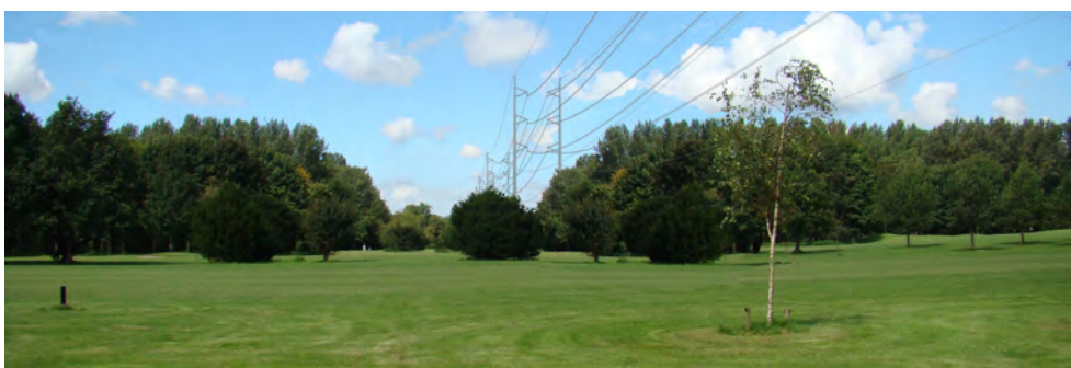
Fig. 4.2.3e: Foto-inpassing van de situatie na realisatie 380kV verbinding.
